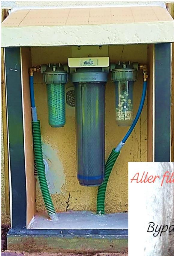
Système bypass intégré dans la **trappe** d'arrivée d'eau extérieure.
